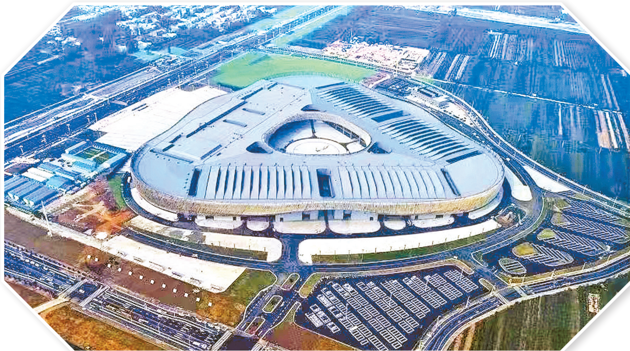
航拍装配式轻钢大型场馆。(资料图片)
