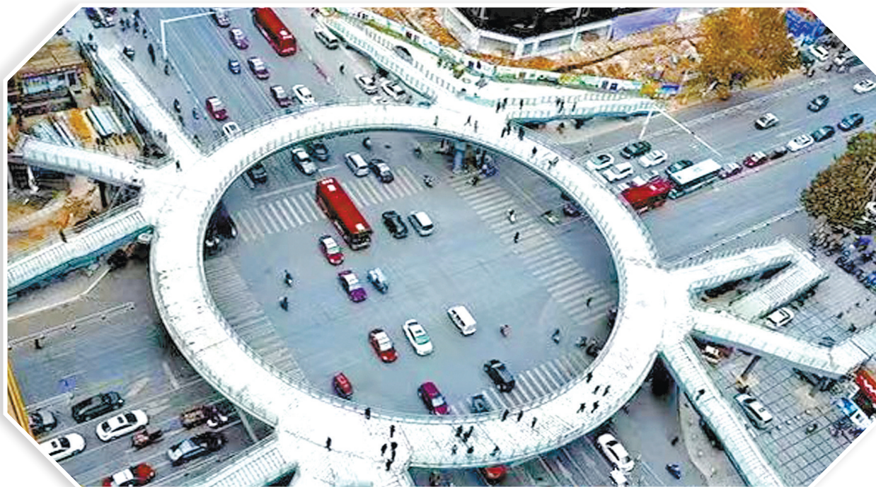
市区乐山大道与解放大道交叉口装配式轻钢立交桥。(资料图片)
